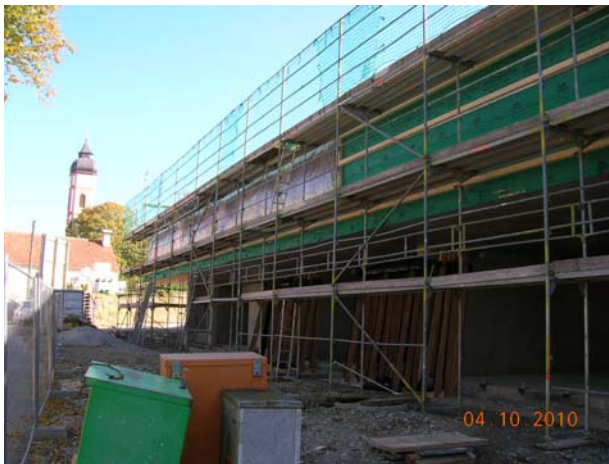
Blick von der Abt-Thoma-Straße zur Kirche (Unterkonstruktion für Fassadenbekleidung ist bereits begonnen)
