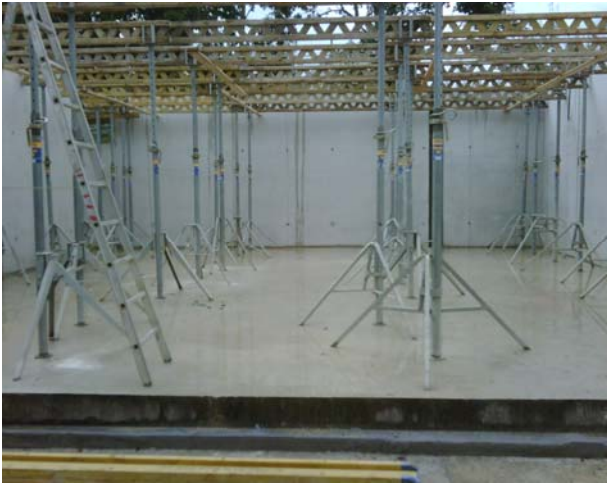
Vorbereitung zum Betonieren der Decke über EG
