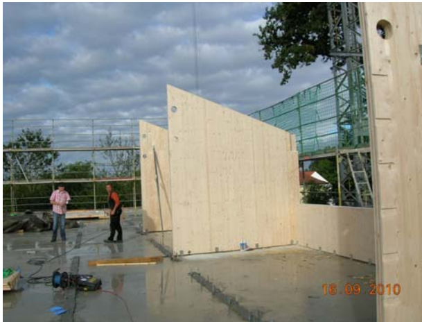
Beim Aufstellen der Holzfertigteile im OG
