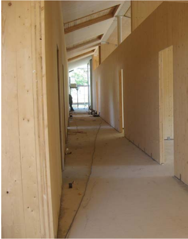
Blick nach Osten entlang des Flurs im OG
