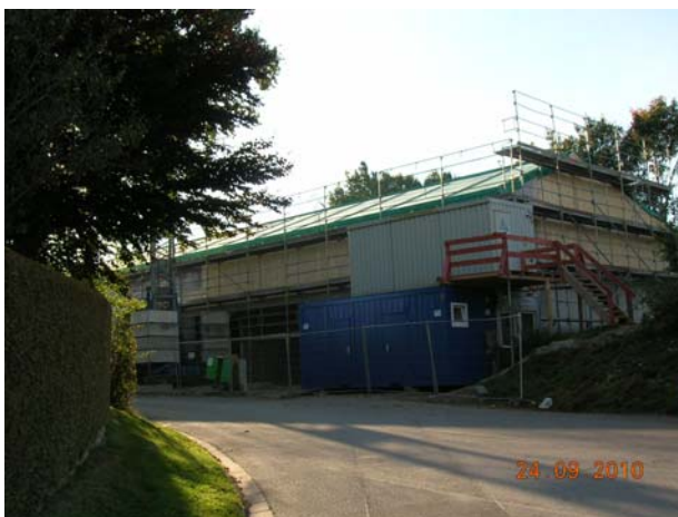
Blick von der Gehagstraße nach Südosten
