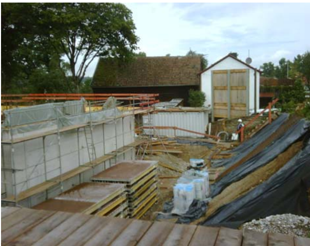
nordöstliche Gebäudeecke: EG ist bereits betoniert
